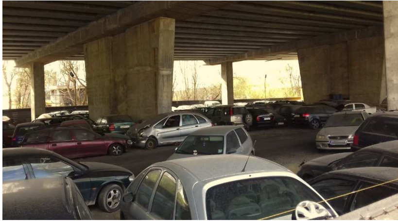
Fot. 6. Zagospodarowanie terenu pod Estakadą Rakocznego.
