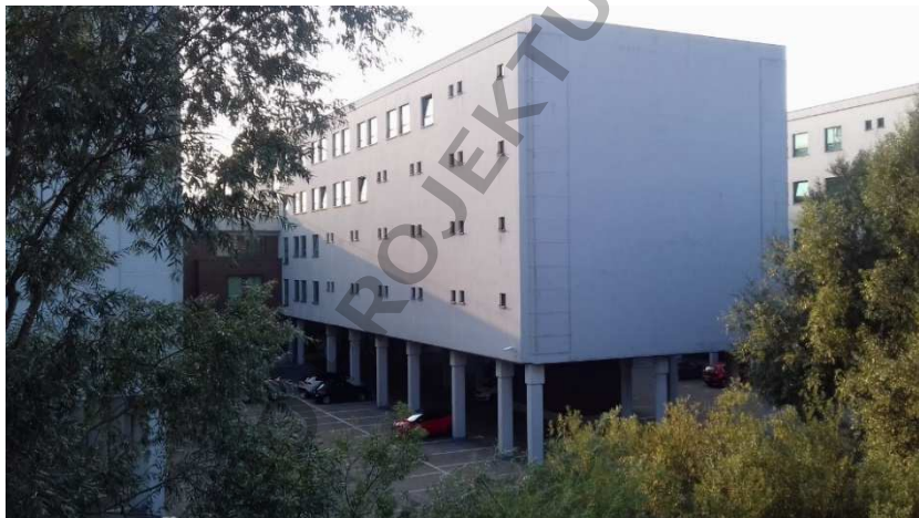
Fot. 8. Fragment zabudowy budynku Sądu Rejonowego Gdańsk-Północ.
